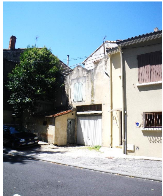
Photo 4 : Ancienne chapelle ? (garage au bas, studio à l'étage)
