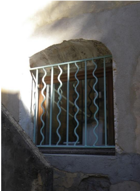
Ébrasure concave en pierre de taille d'une fenêtre (élément permettant une datation ?)
