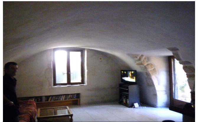
Studio aménagé à mi-hauteur du bâtiment
