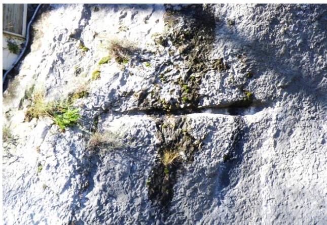
Profonde entaille horizontale de fixation
